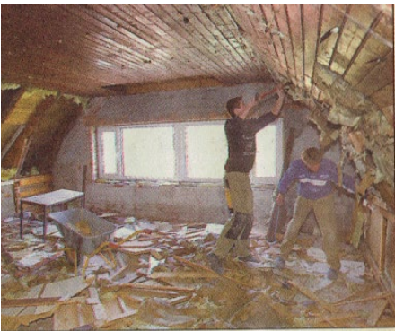
Øverste etage under ombygning. Jesper Brøndum og Jimmi Jacobsen i gang med hver sit koben. Loftet skal føres op i kip. Ni kviste er desværre blevet sparet væk for at få budgettet til at hænge sammen.
